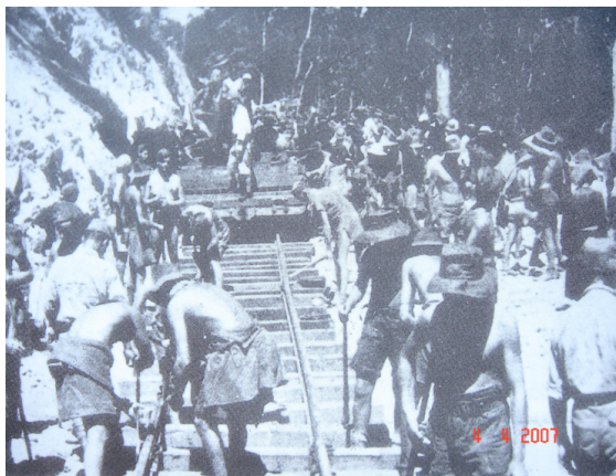
ภาพที่ 2 เชลยศึกทหารสัมพันธมิตรขณะทำการก่อสร้าง ทางรถไฟสายมรณะ (Australian War Memorial)
